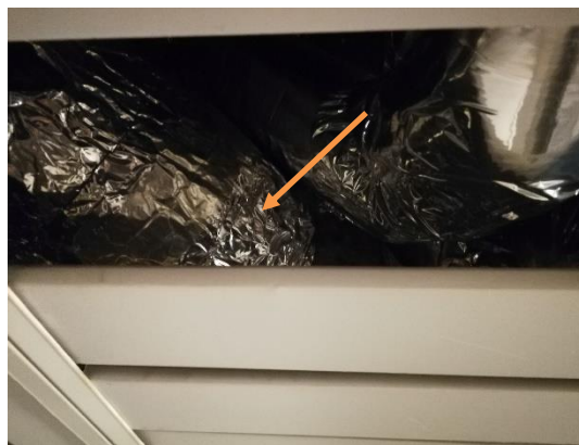
Abbildung 8: KMF-Rohrummantelung, aluschiert.
