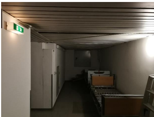
Abbildung 7: Flurbereich mit KMF-ummantelten Rohrleitungen oberhalb der Abhängung
