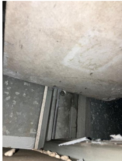
Abbildung 6: Detailansicht Klappenblatt (geöffnet)
